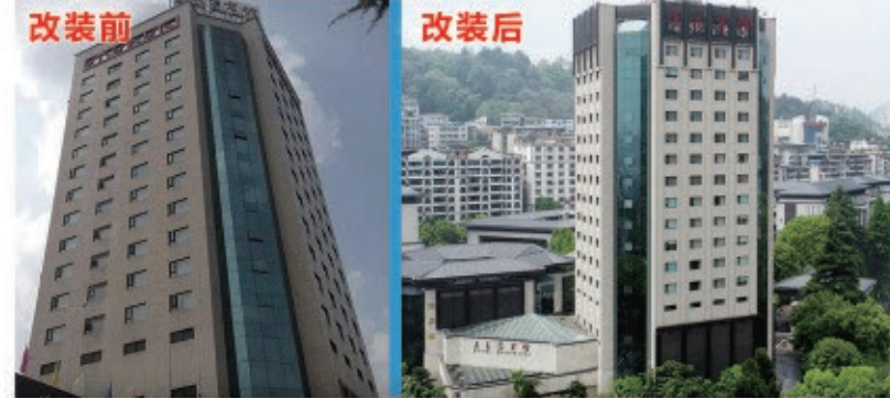
贵州遵义宾馆 采用新盛筑能水包砂仿石材保温装饰一体板
