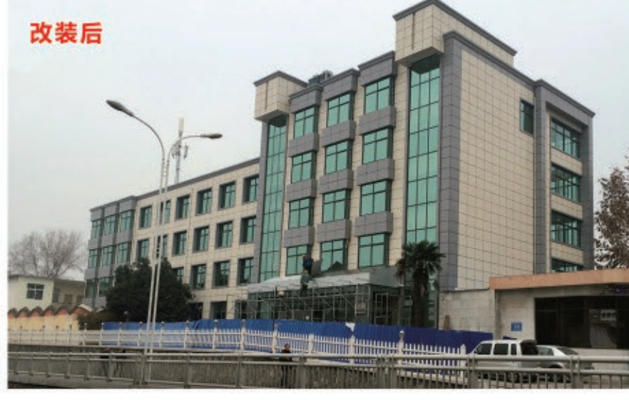
新乡电力宾馆 采用新盛筑能仿石材保温装饰一体板
