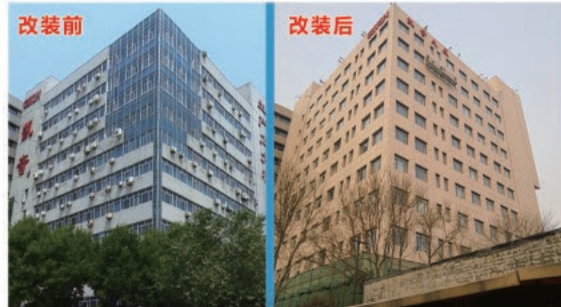
北京凯奇大厦 采用新盛筑能陶瓷薄板保温装饰一体板
